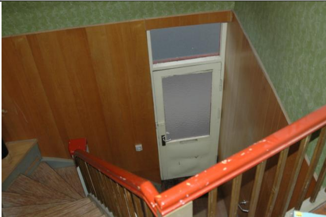
Hoveddør til Nybrovej 156 og indvendig trappe.
