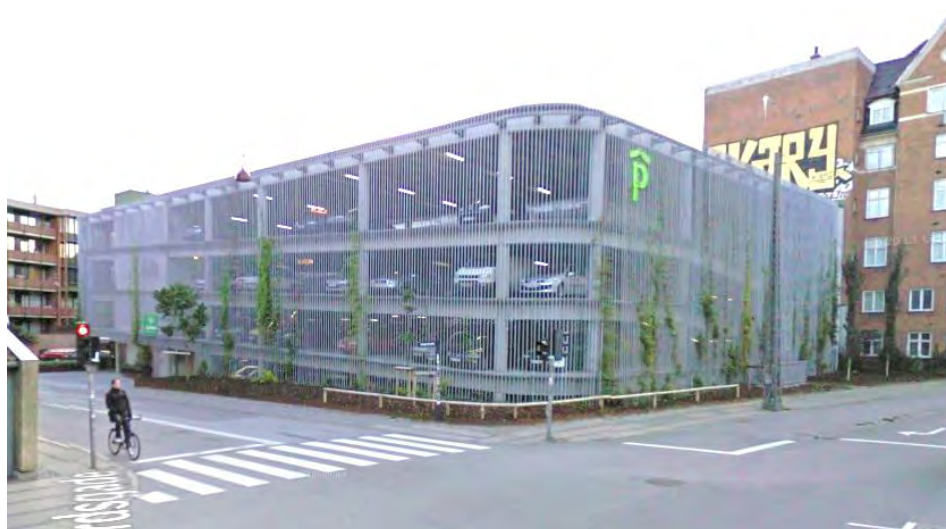
Eksempel på parkeringshus med spredt begrønning bestående af klatreplanter. (Referencefoto)
