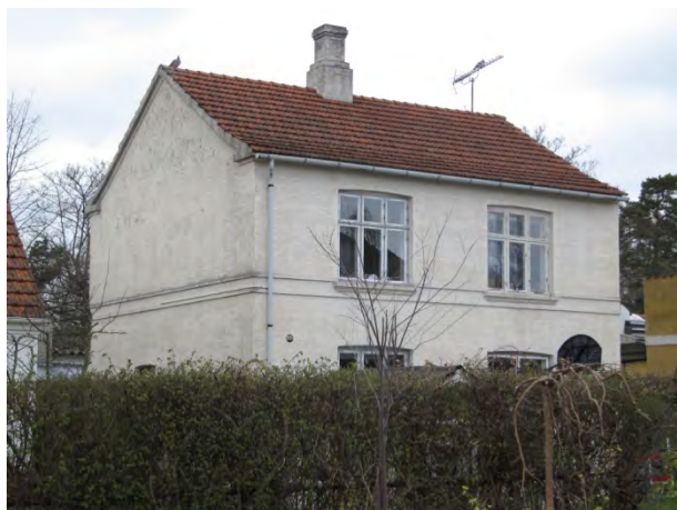
Gl. Lundtoftevej 35A. Opført 1910.
