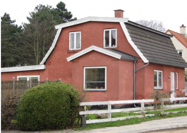
Gl. Lundtoftevej 39. Opførelsesår ukendt. Tilbygget 1900.
