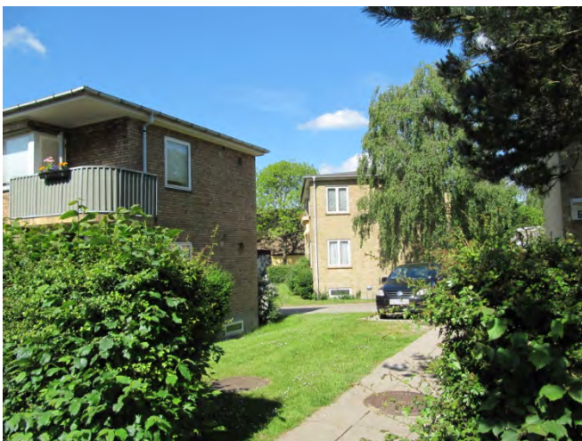
Funktionalistiske bygninger i 2 etager på Toftegærdet 2
