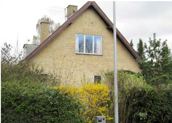
Ved Smedebakken 14. Opført 1923. Nedrives.
