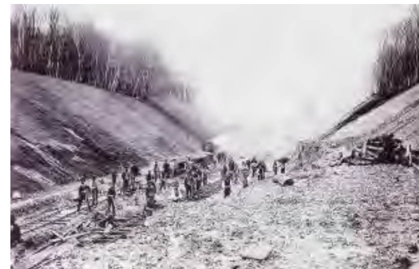
Mellem 1886-88 blev Fæstningskanalen udgravet som militært anlæg. Fotoet viser udgravningen gennem Ermelundskilen. Kilde: Statens Forsvarshistoriske Museum.
