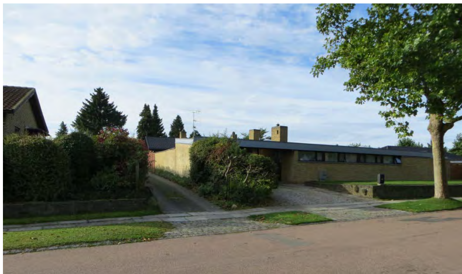
Hvidegårdsparken 55 en af de bygninger som i lokalplanen udpeges som bevaringsværdige.
