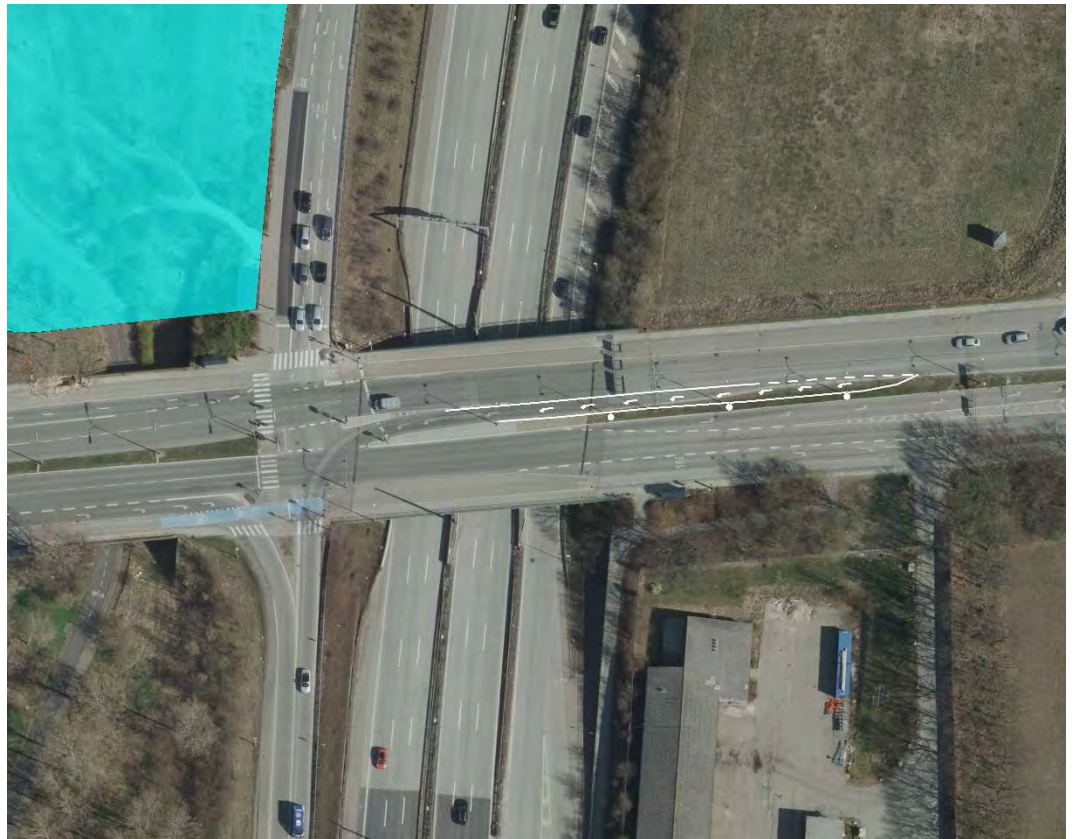
Figur 7: Udvidelse af venstresvingsbane på Klampenborgvej mod Helsingørmotorvejen.
