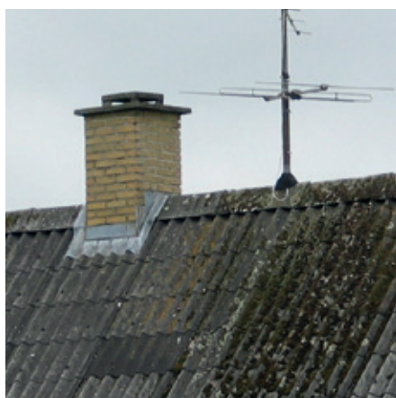
Ældre eternittage indeholder som oftest asbest.
