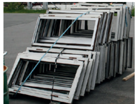
Vinduesrammer forurenede med PCB fra monterede PCB-holdige termoruder. Skal som udgangspunkt bortskaffes som farligt affald.
