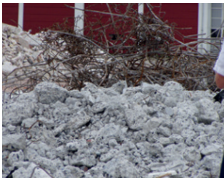
Nedknust beton og armeringsjern. Betonen genanvendes og jernet smeltes om.
