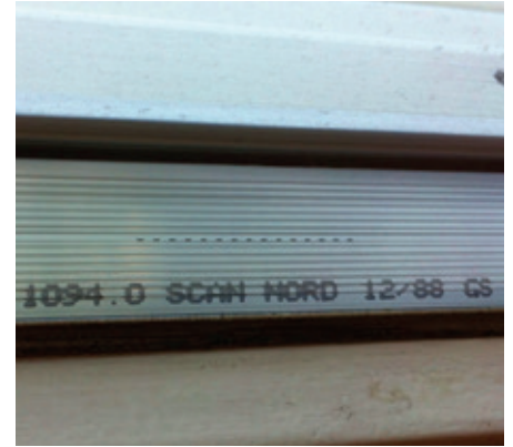
Prægningen i rudens afstandsliste viser, at ruden er fremstillet i december 1988 (12-88). Ruden indeholder derfor ikke PCB.
