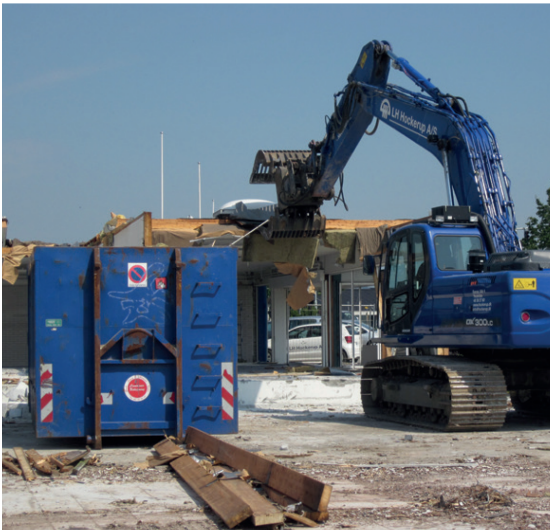
Nedrivning hvor affaldet sorteres umiddelbart.
