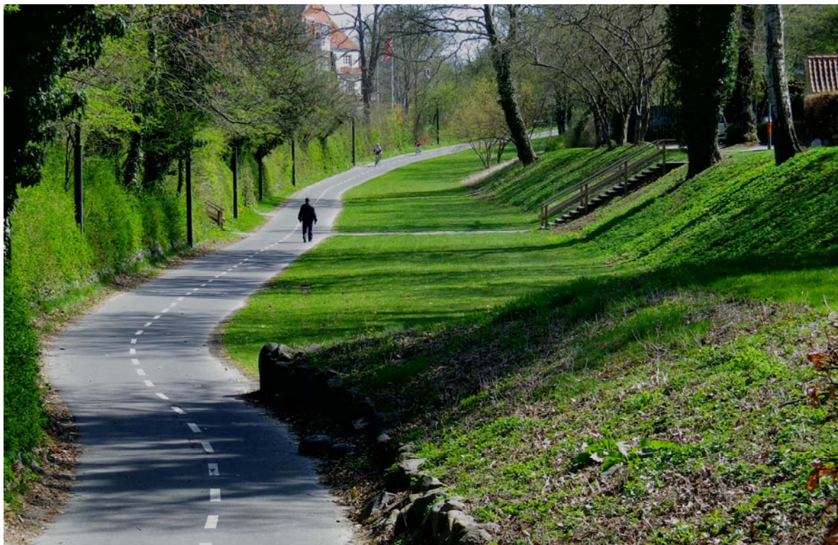
Kanalstien mellem Stades Krog og Toftebæksvej, eksisterende forhold
