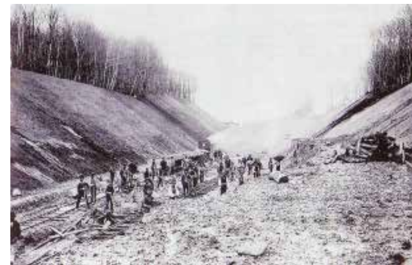
Mellem 1886-88 blev Fæstningskanalen udgravet som militært anlæg. Fotoet viser udgravningen gennem Ermelundskilen. Kilde: Statens Forsvarshistoriske Museum.
