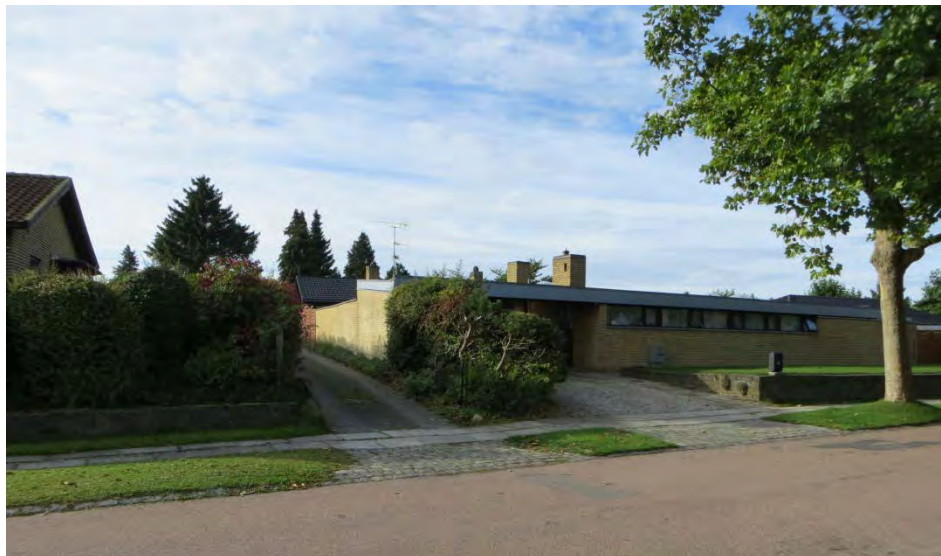
Hvidegårdsparken 55 en af de bygninger som i lokalplanen udpeges som bevaringsværdige.
