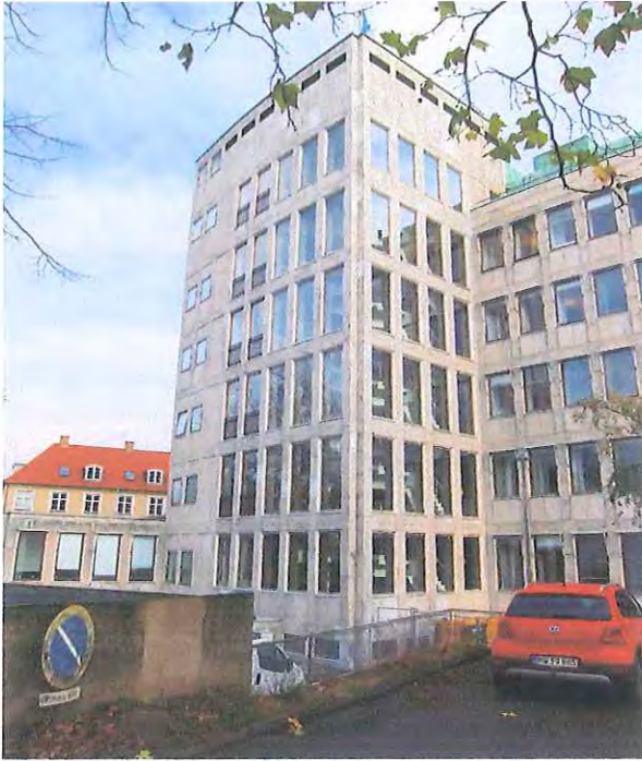
Trappetårnet med vinduer mod vest og syd. Øverst en række glughuller som afslutningsbånd
