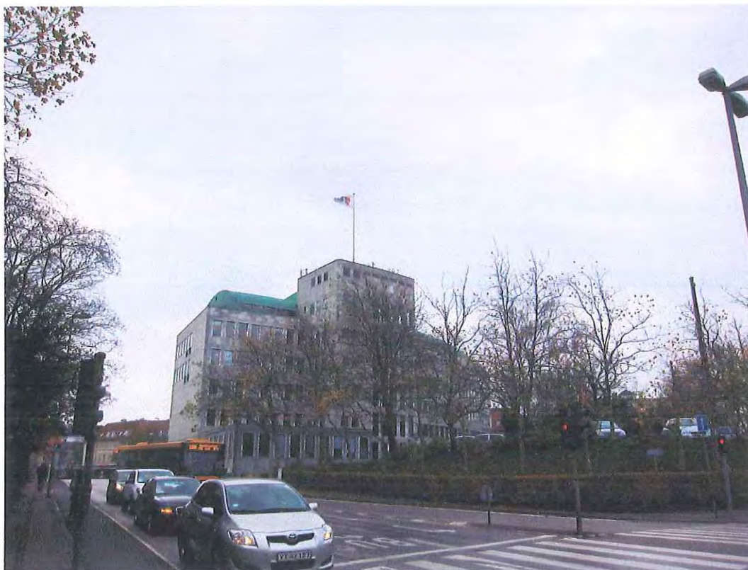
Trappetårnet markerer rådhuset fra stationspladsen
