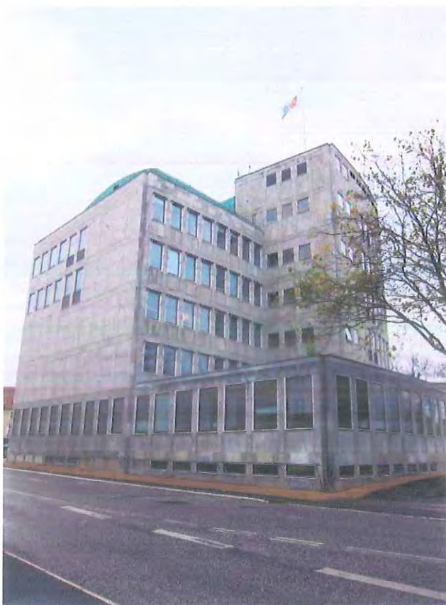
Den tilbyggede længe og trappetårnet
