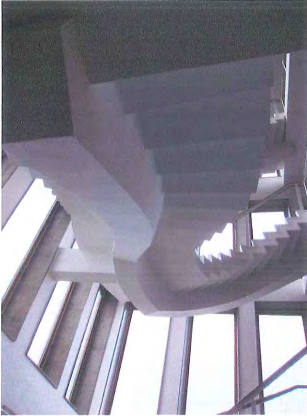
Trappens vedhæftning til betonskelettet
