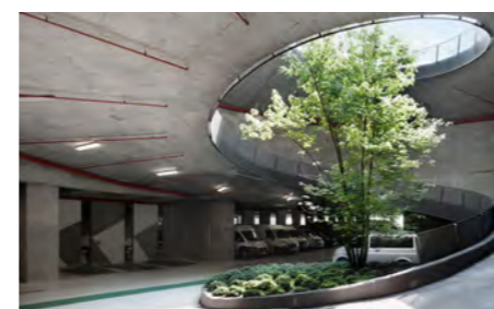
Atrium med vegetation og lys i et råt bus
